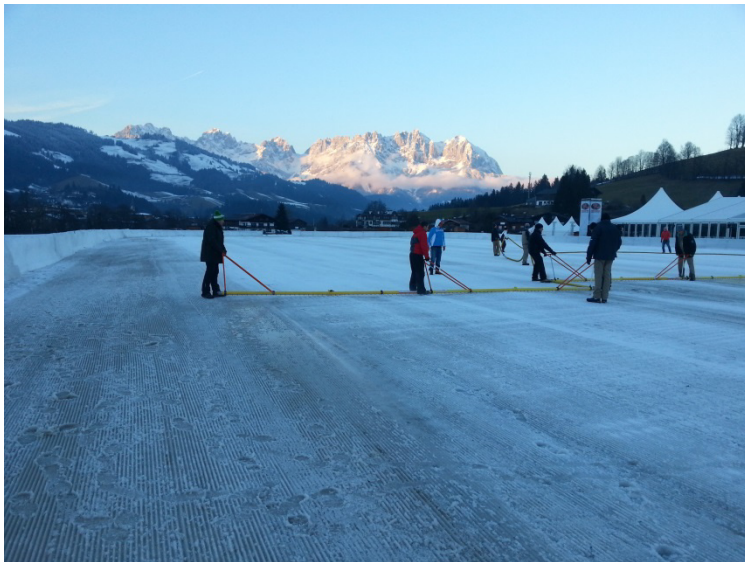
Präparation Polo Platz Kitzbühel mit Injektionssprühbalken
